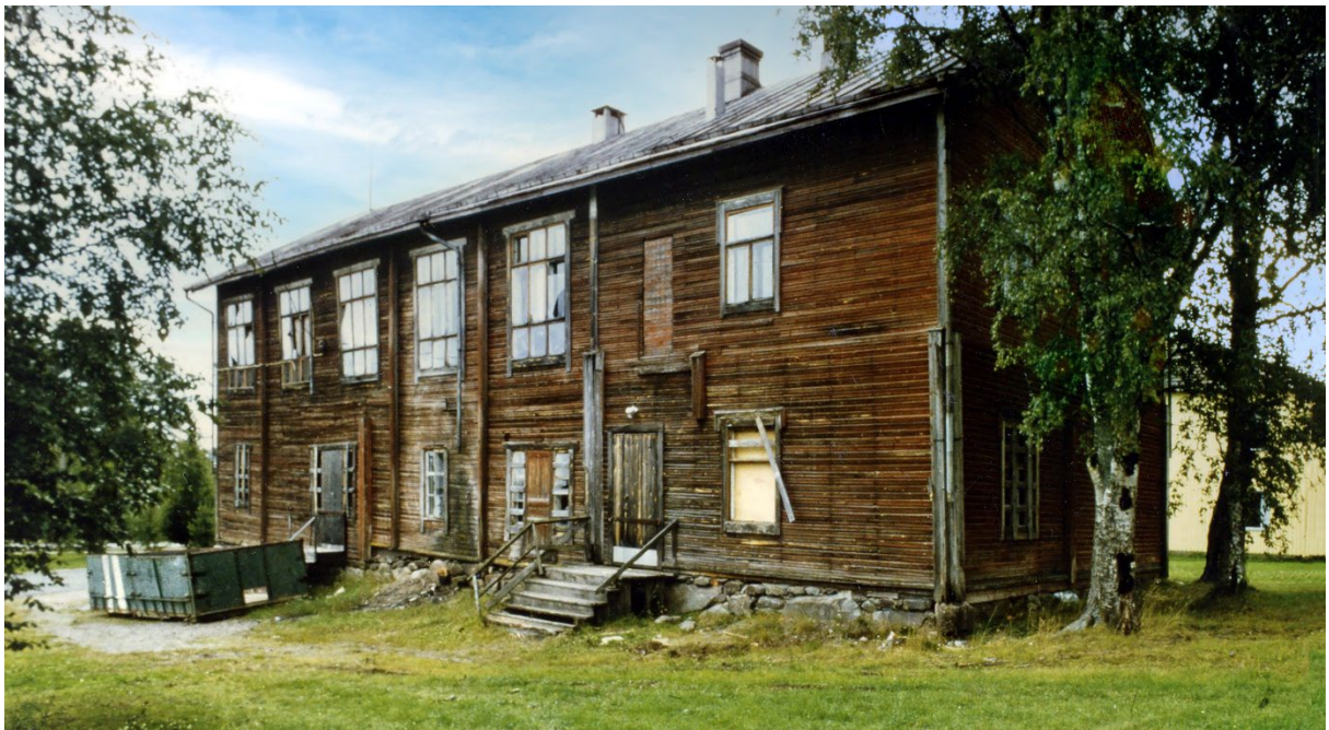
10. Työväentalo remonttikunnossa. – Tokoi-museo
